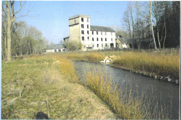
Ouvrage de Roizy
